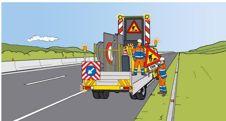
**Figura 27 – Chiusura della corsia di marcia: scarico ed installazione del segnale di lavori in corso sul margine destro**
