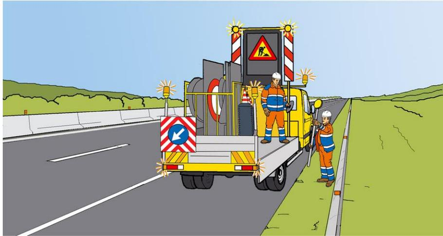
**Figura 25 – Chiusura della corsia di marcia: scarico della segnaletica dal mezzo**
