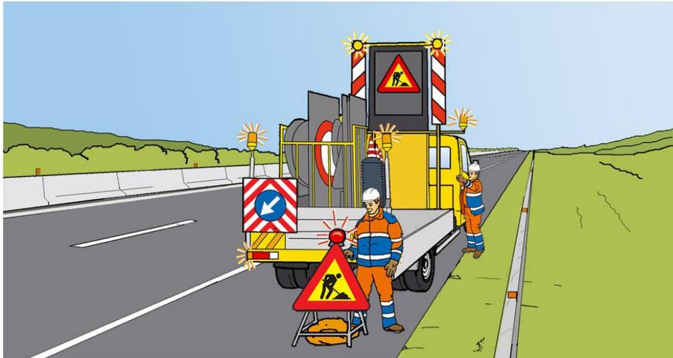
**Figura 23 – Chiusura della corsia di emergenza: installazione del cartello di lavori in corso**
