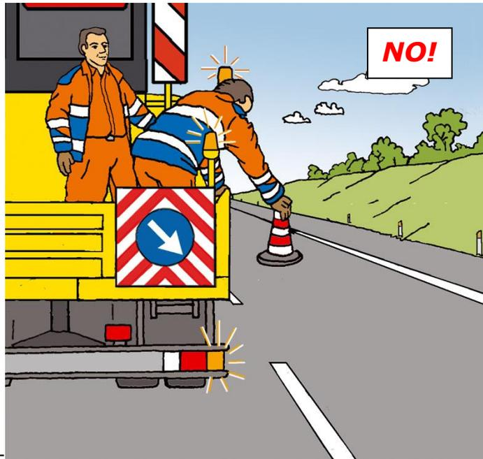
**Figura 60 – Posizionamento dei coni o defleco: comportamento scorretto**
